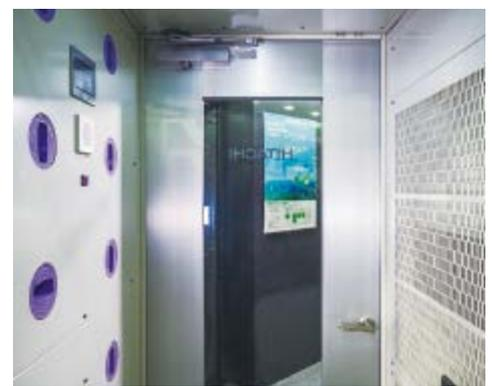
フラッタージェットノズルと片面全面吸い込み構造
